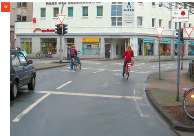
3a-c: Auch von einem Radweg aus können Radfahrende in einem aufgeweiteten Radauf- stellstreifen geführt werden.
