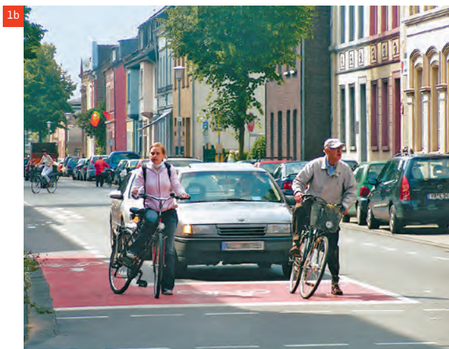
1a/1b Rot eingefärbter aufgeweiteter Rad- aufstellstreifen mit – in der Knotenpunkt- zufahrt – ebenfalls rot eingefärbtem Schutzstreifen
