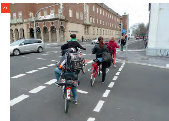
7a–d Der breite Radfahrstreifen gewährleistet in Zusammenhang mit der fahrradfreundlichen Signalisierung auch die Bewältigung hoher Radverkehrsmengen.
