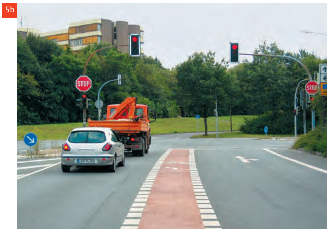
5a/b In der Knotenpunktzufahrt wird der Radfahrstreifen um einen rot eingefärbten Linksabbiegestreifen für den Radverkehr ergänzt.
