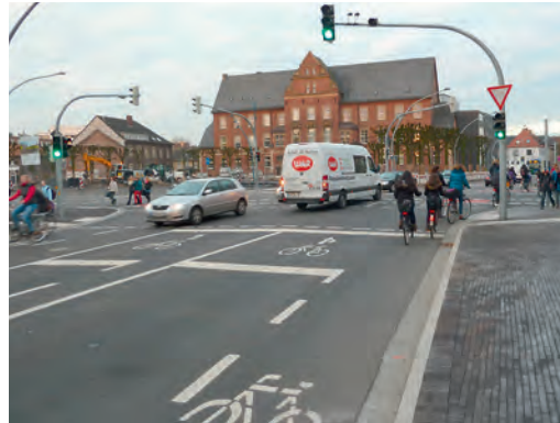
12 Aufgeweitete Radaufstellstreifen mit vorgelagerten Schutzstreifen für geradeaus fahrenden und links abbiegenden Radverkehr.
