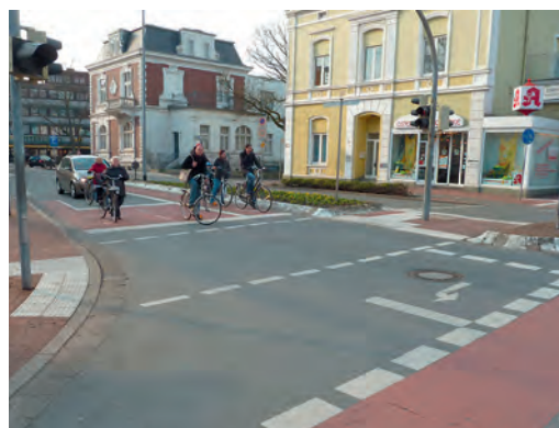
13 Bei starkem Radverkehr verbessern sich durch das pulkartige Abfließen der bei Rot gestauten Radfahrenden auch die Bedingungen für den Kfz-Verkehr.
