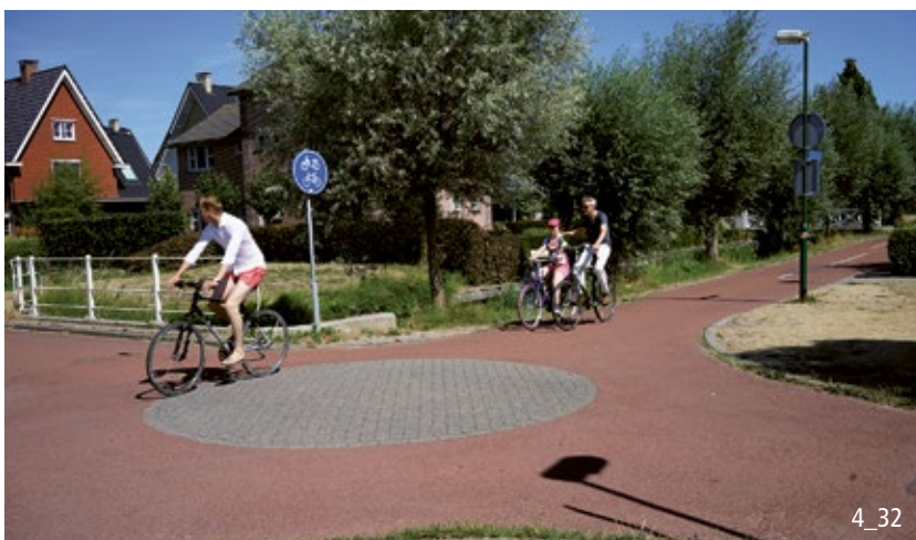
Radwegkreuzung mit Rechtsvortritt. Überfahrbare Mittelinsel erhöht die Erkennbarkeit der Kreuzung.
