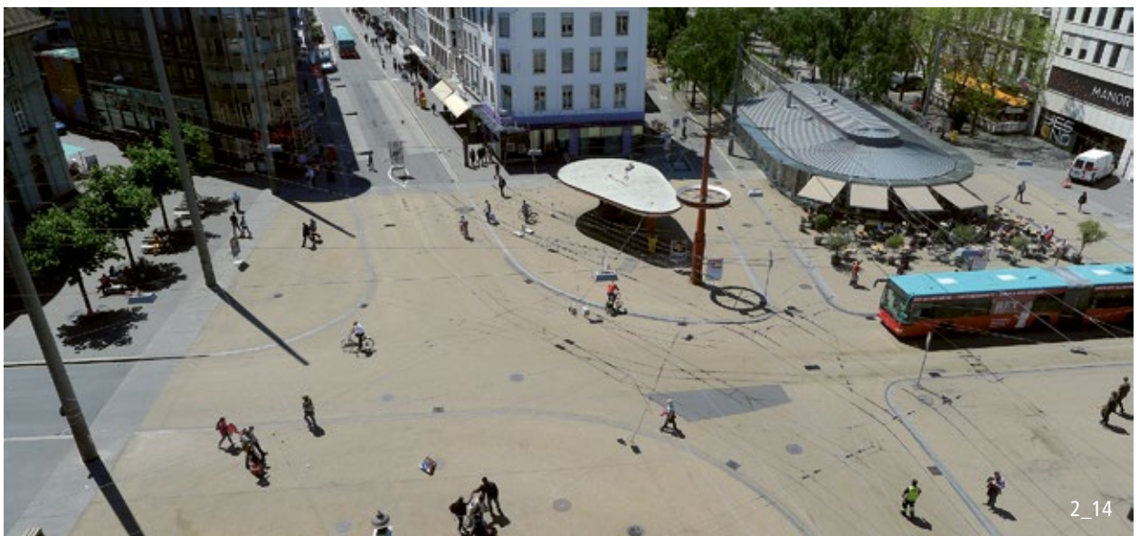
Platz statt Kreuzung: Shared-Space mit Begegnungszone.
