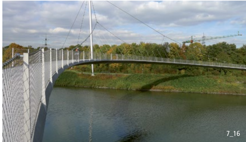
Rampen mit moderater Steigung erhöhen den Komfort (Deutschland).
