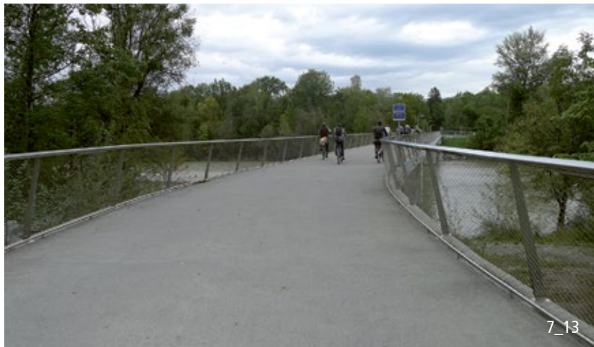
Erlaubt mittlere Frequenzen sowie komfortable Begegnungen und Überholmanöver: 5 m breite Brücke für Fuss- und Veloverkehr (Österreich).
