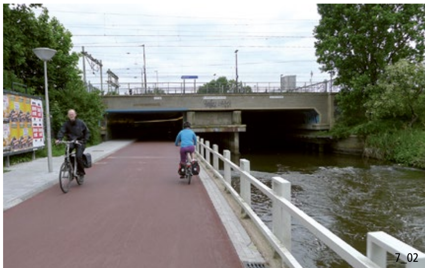
Brücken und Unterführungen ohne zuführende Rampen sind besonders komfortabel (Niederlande).
