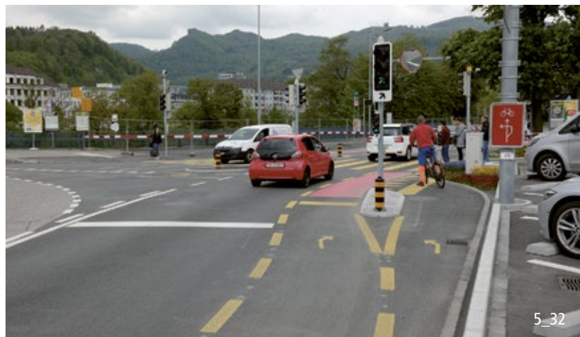
Indirektes Linksabbiegen mit Haltebucht.
