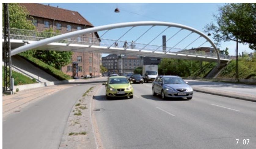
Ausnützen der topografischen und stadträumlichen Gegebenheiten für den Bau einer Brücke (Dänemark).
