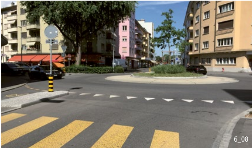
Kreiselzentrum in der Strassenachse, Innenring deutlich erkennbar und bedingt überfahrbar.
