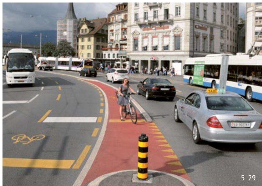
Geschützter Linksabbiegebereich nur für Veloverkehr.
