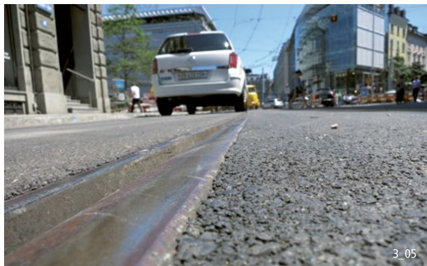
Der Gleisüberstand sollte beim Einbau nicht mehr als 3 mm betragen.
