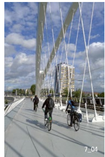
Gemeinsamer Fuss- und Veloverkehrsreich auf Brücke mit Tram (Frankreich).
