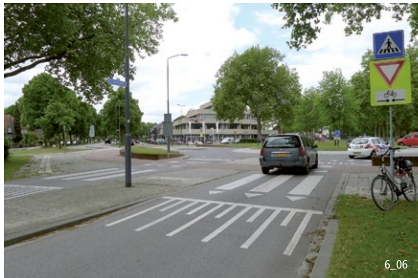
Vertikaler Versatz vor dem Kreisel reduziert die Geschwindigkeit (Niederlande).
