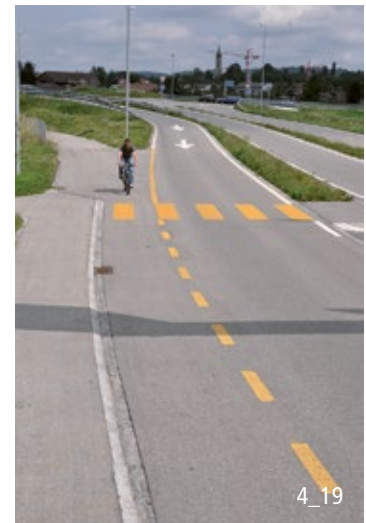
Rückführung eines Radwegs mit Trennstreifen.
