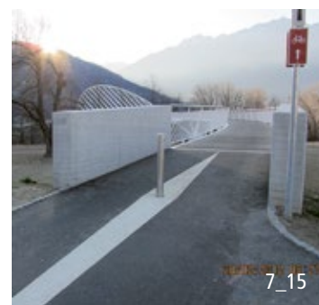
Absperreffosten mit korrekter Markierung. Der Pfosten verhindert das Befahren der Rampe mit Motorfahrzeugen.
