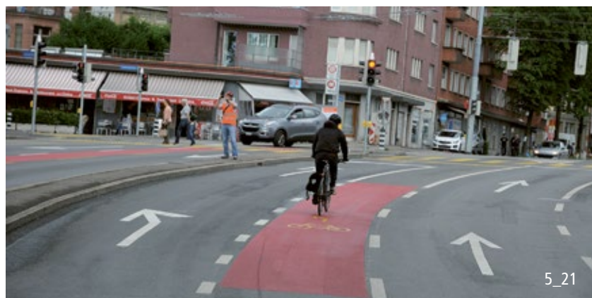
Radstreifen in Mittellage müssen mind. 1.80 m breit und dürfen nicht länger als 30 m sein.
