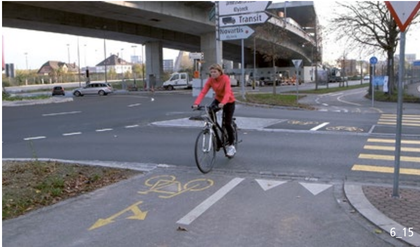
Zweirichtungsradweg mit nicht vortrittsberechtigter Querung.
