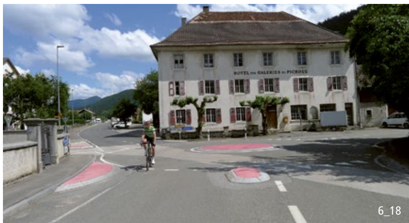
6_18 Minikreisel d = 15 m, Kreiselfahrbahn ohne Innenring 5.25 m, Mittelinsel gepflästert d = 4.5 m, Mittelinsel überfahrbar, aber erhöht (Rand = 7.5 cm hoch, Mitte ca. 12 cm hoch); Leitinseln ebenfalls erhöht und farblich hervorgehoben.
