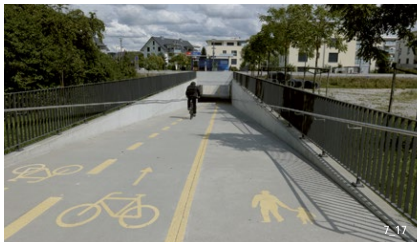
Geradlinige und dadurch übersichtliche Unterführung mit angenehm befahrbaren Rampen.
