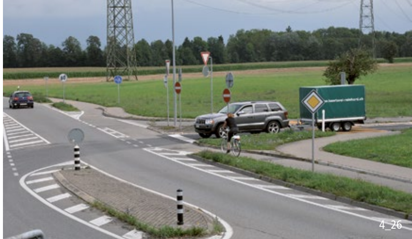
Vortrittsberechtigte Querung über eine einmündende Strasse.
