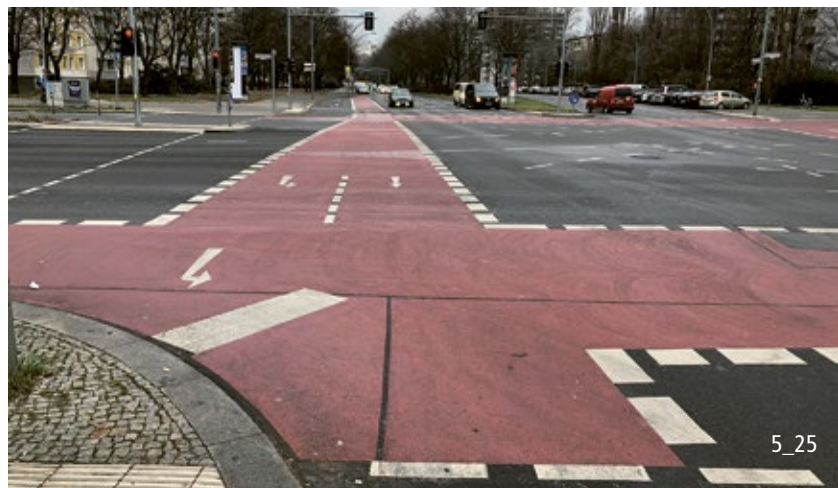
Indirektes Linksabbiegen als Knotensystem (Deutschland).
