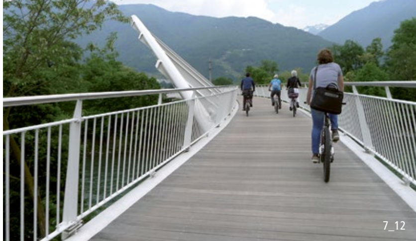
Eine Brücke mit 3 m lichter Breite ist ausreichend für sehr geringe Frequenzen.
