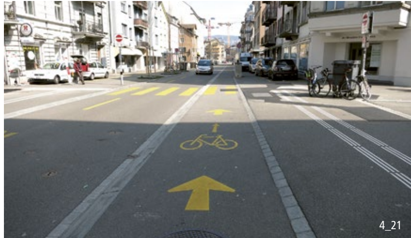
Vortrittsberechtigter Radweg in Kombination mit einer Trottoirüberfahrt.
