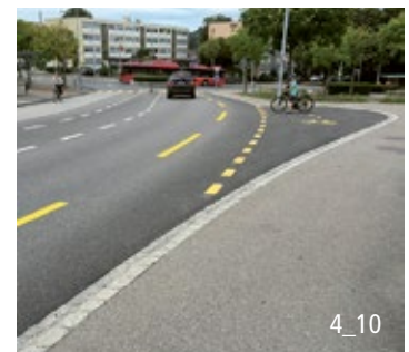
Indirektes Linksabbiegen ohne LSA vor Schulhaus; Schülerpuls erfordern eine grosszügige Aufstellfläche.
