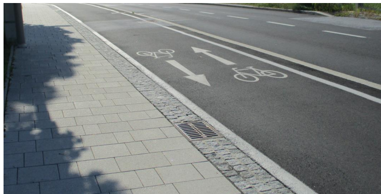
Abbildung 19: Begrenzung von Radwegen gegenüber Gehsteigen in Graz; Foto: KfV Sicherheit-Service GmbH
