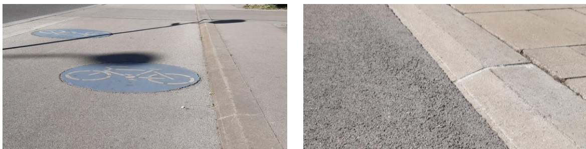
Abbildung 17: Standardlösung der Begrenzung von Radwegen gegenüber Gehsteigen in Wien; Fotos: KfV Sicherheit-Service GmbH
